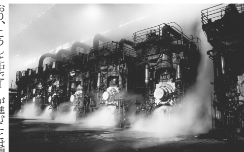
労災対策など安全面でもIoT活用へ（新日鉄住金君津製鉄所熱延工場の仕上げ圧延ライン）
