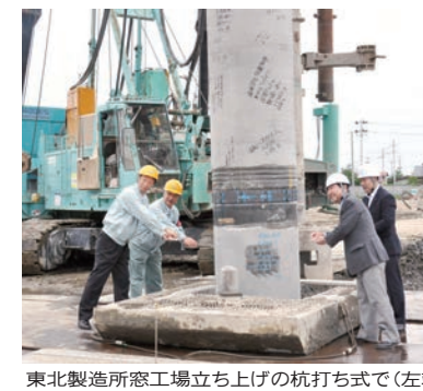
東北製造所窓工場立ち上げの杭打ち式で(左端)
